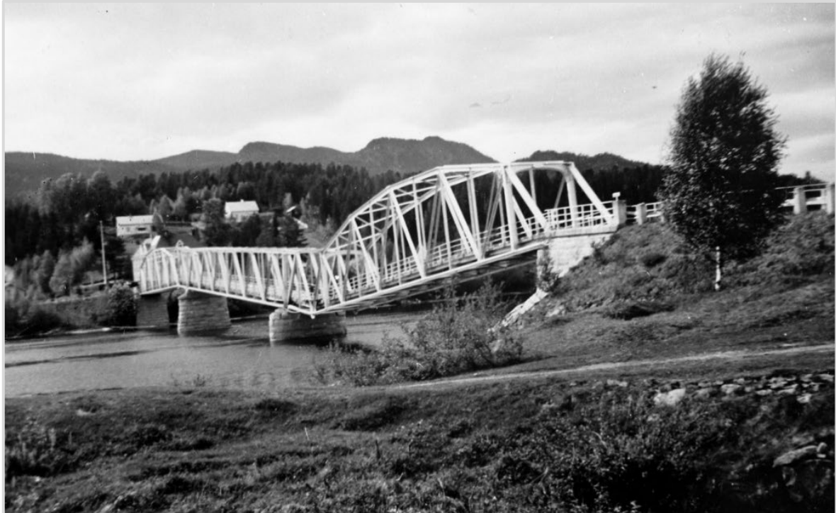
Figur 10.7: Stai bru etter sprengningen i 1940.
