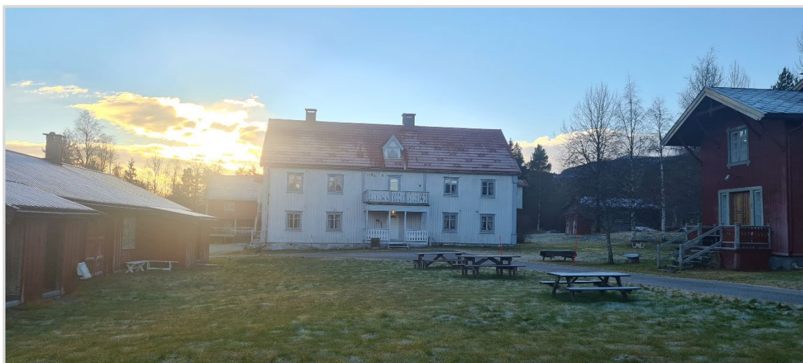
Figur 9.12: Nystu Trønnes. Hovedbygningen (kalt Rødbygningen) til høyre, sommerstua til venstre, og pensjonærboligen (kalt Kvitbygningen) midt i bildet. Foto: Anja Ø. Ryen
