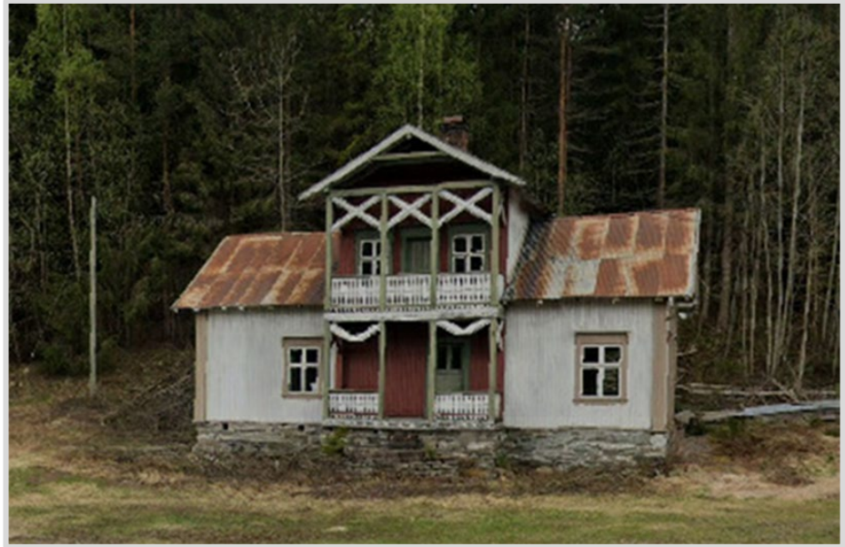
Figur 8.23: Skysstasjonen på Stai.
