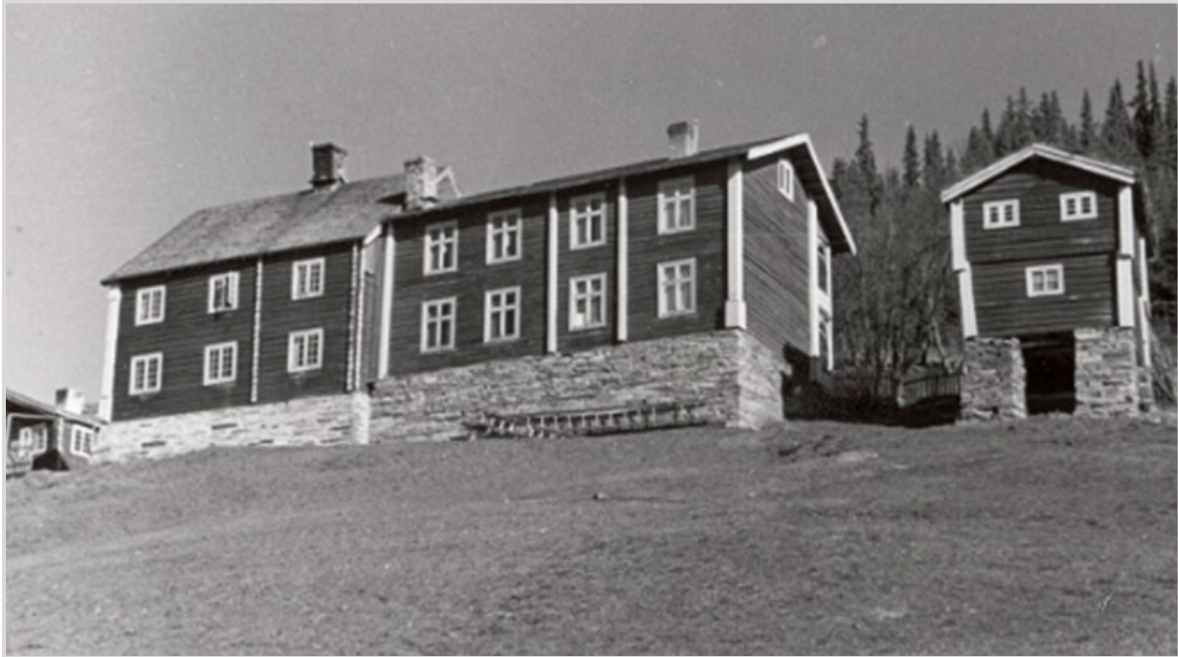
Figur 8.22: Sollien i Sollia, bilde fra Riksantikvaren.
