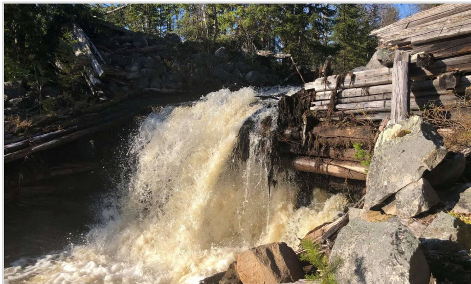
Figur 6.5: Fløtningsanlegg ved Rokkdammen. Foto: Janne Mellum
